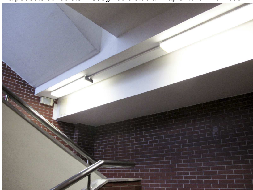
Na podestě schodiště IB000g vedle studia - zaplentování rozvodů VZT.
